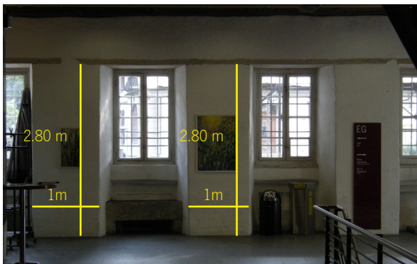
EG, Wand Süd
