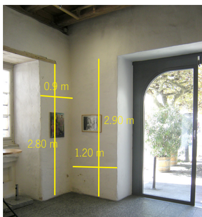
EG, Eingang West, Ecke (verputzt)
