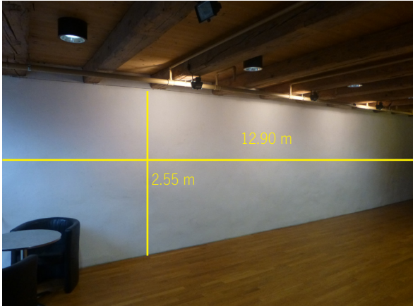
1. OG, Wand Nord (verputzt)
