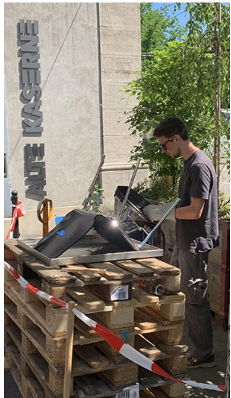
Renovationsarbeiten in der veranstaltungsfreien Zeit: Hier führt ein Lernender Schweißarbeiten an einem der 700 Stühle im Haus durch.
